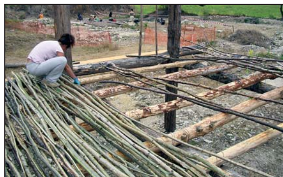
■ Fig. 7 Mise en place du plancher
