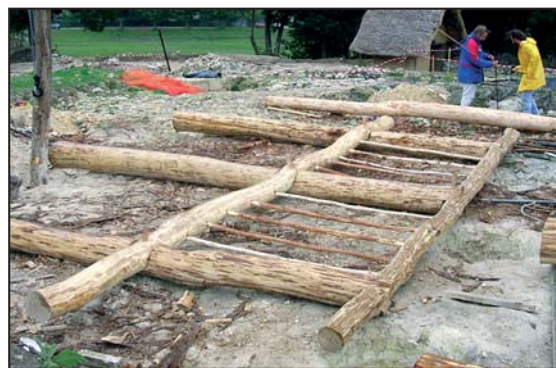
■ Fig. 5 Pan de bois assemblé au sol
