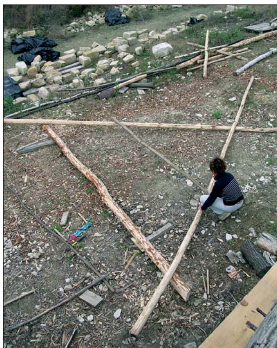
■ Fig. 9 Assemblage au sol d'une ferme
