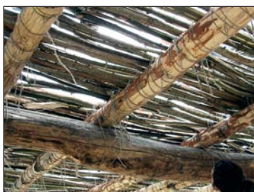
■ Fig. 8 Vue sous le plancher
