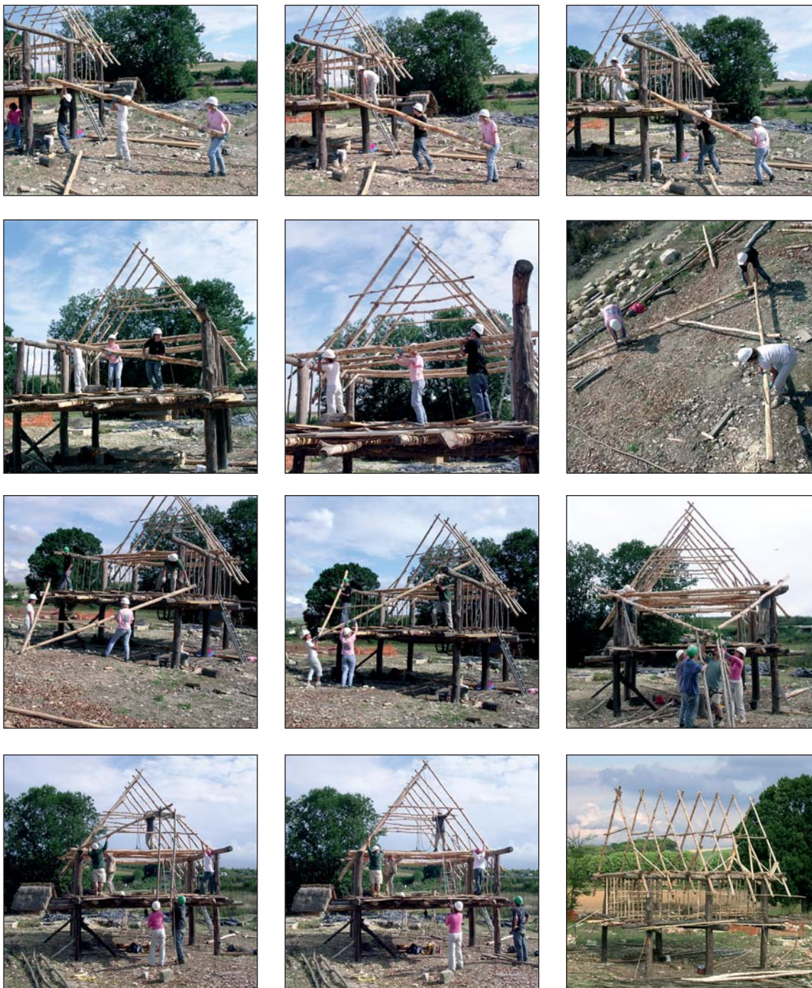
■ Planche 2: 1-12 La mise en place des fermes de la charpente
