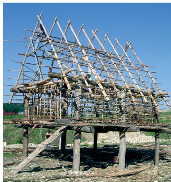
■ Fig. 12 Mise en place des voliges et du clayonnage
