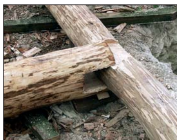
■ Fig. 4 Assemblage par enfourchement
