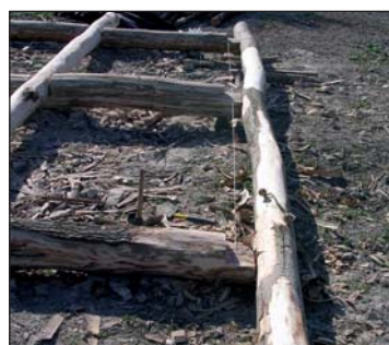
■ Fig. 3 Assemblage par tenon-mortaise
