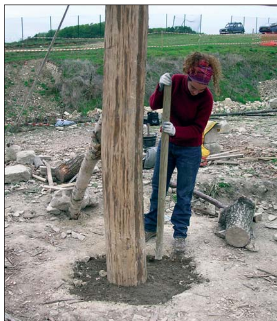
■ Fig. 6 Tassement de la terre
